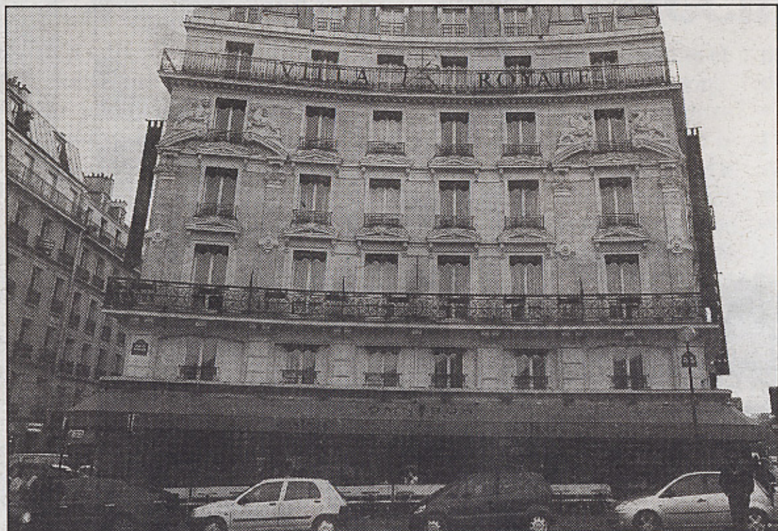
PLACE PIGALLE, IX e . Les travaux pour transformer en restaurant cet ancien bar où se côtoyaient des artistes peintres du XIX e siècle, viennent de commencer. (LP/OLIVIER CORSAN.)
